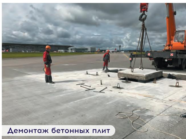
Демонтаж бетонных плит
