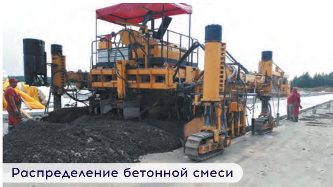
Распределение бетонной смеси
