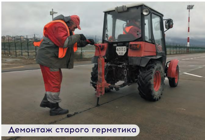
Демонтаж старого герметика
