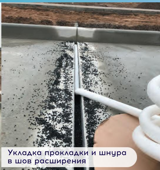
Укладка прокладки и шнура в шов расширения
