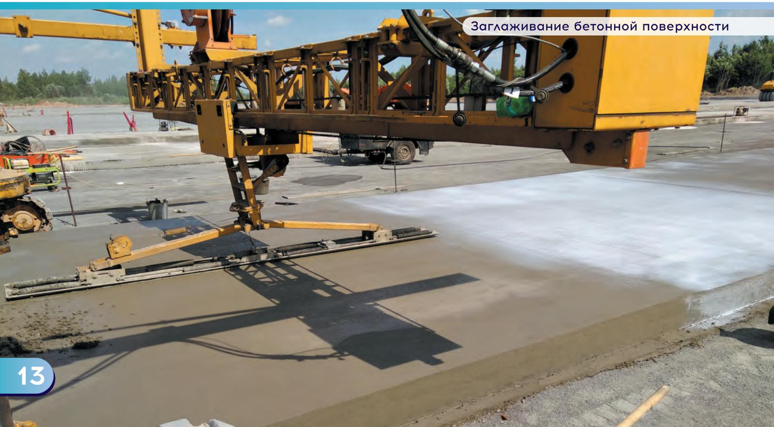
Заглаживание бетонной поверхности
